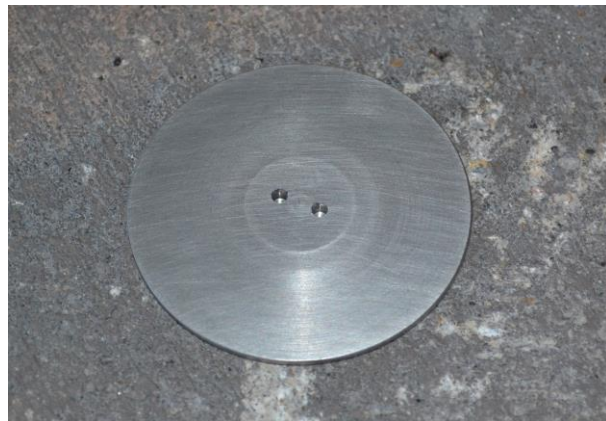
Fig 4. Copertura di Sicurezza installata
