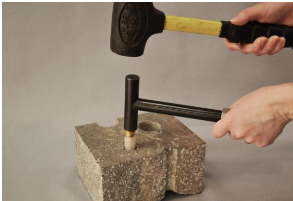
Fig 2. Installazione del Vapor Pin™.
