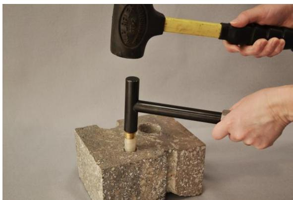
Fig 2. Installazione del Vapor Pin™.
